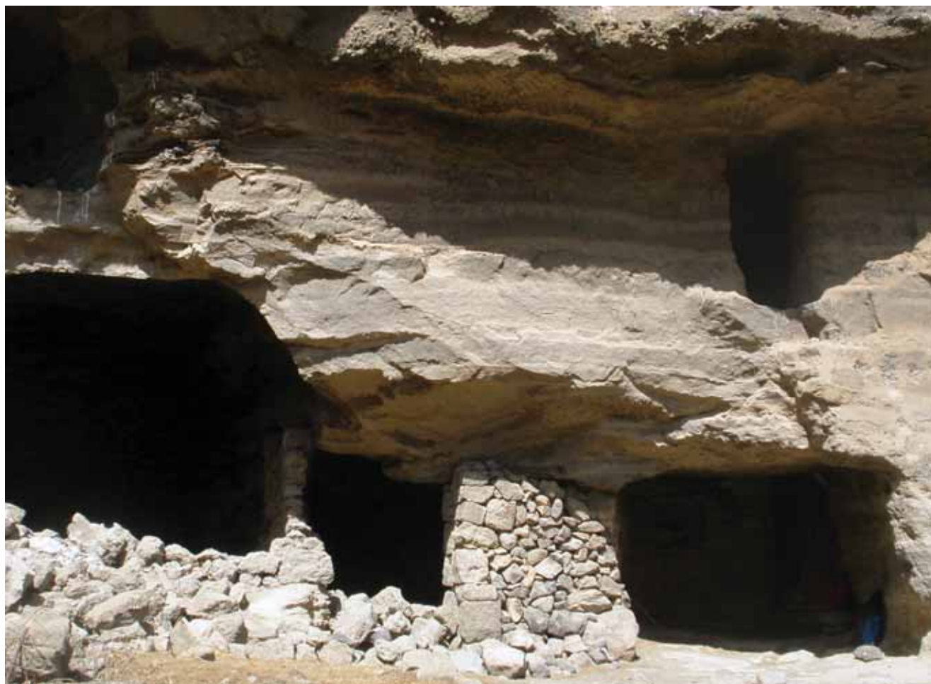
Figura 4.a.7. La relativa fragilidad de los escarpes y tobas volcánicas que afectan a las manifestaciones trogloditas, obligan a realizar un monitoreo permanente y acciones de saneamiento para garantizar su conservación. © Cabildo de Gran Canaria
