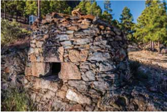
Figura 2.a.197. Horno de pan de la Casa Forestal de Pajonales. Este tipo de infraestructuras domésticas se introdujeron tras la Conquista y sobresalen algunos hornos adosados a solapones y cuevas que siguen la tradición troglodita © FEDAC
