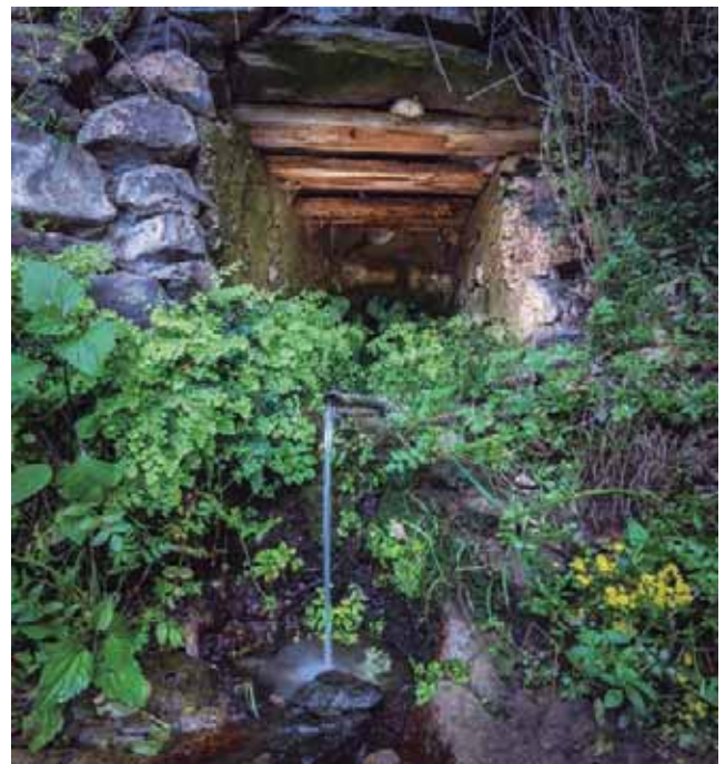
Figure 3.2.37. Pequeña mina de agua (galería filtrante) en El Hornillo © FEDAC
