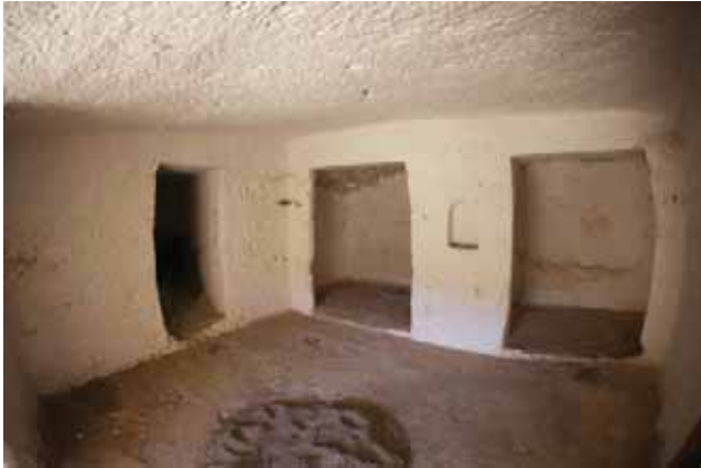
Figura 2.a.95. Distribución interior típica de la casa cueva tradicional. Barranco Hondo. © Julio Cuenca
