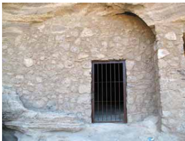
Figura 4.a.6. Con el fin de garantizar la adecuada conservación de los yacimientos, en los casos de riesgo, se ha procedido al cerramiento de los mismos que sólo se abren a las tareas de investigación o a visitas guiadas con riguroso control. © Cabildo de Gran Canaria
