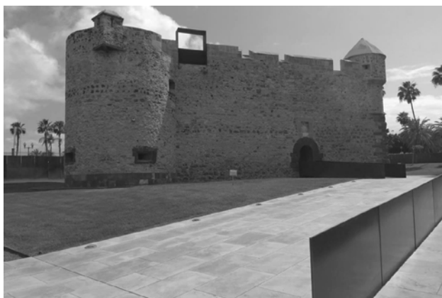
Fig. 6. Castillo de La Luz con algunos de los insertos en acero corten: ventanal-mirador y pasarelas.
