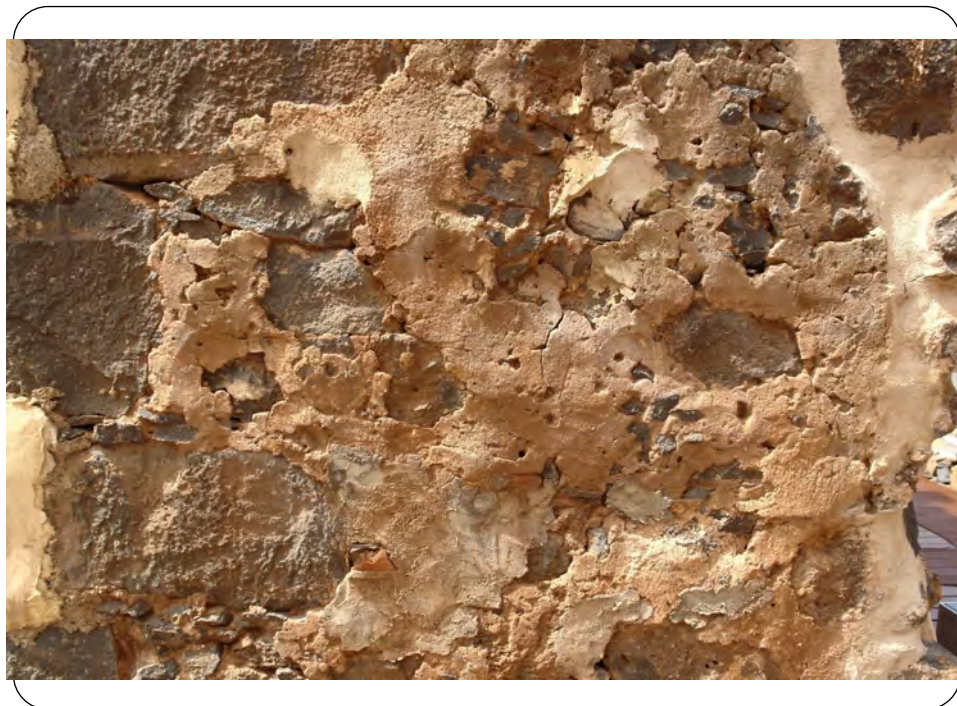
El enfoscado de la ermita de San Miguel, técnica constructiva que se repite en el muro del convento de Santo Domingo. (Foto: elaboración propia).
