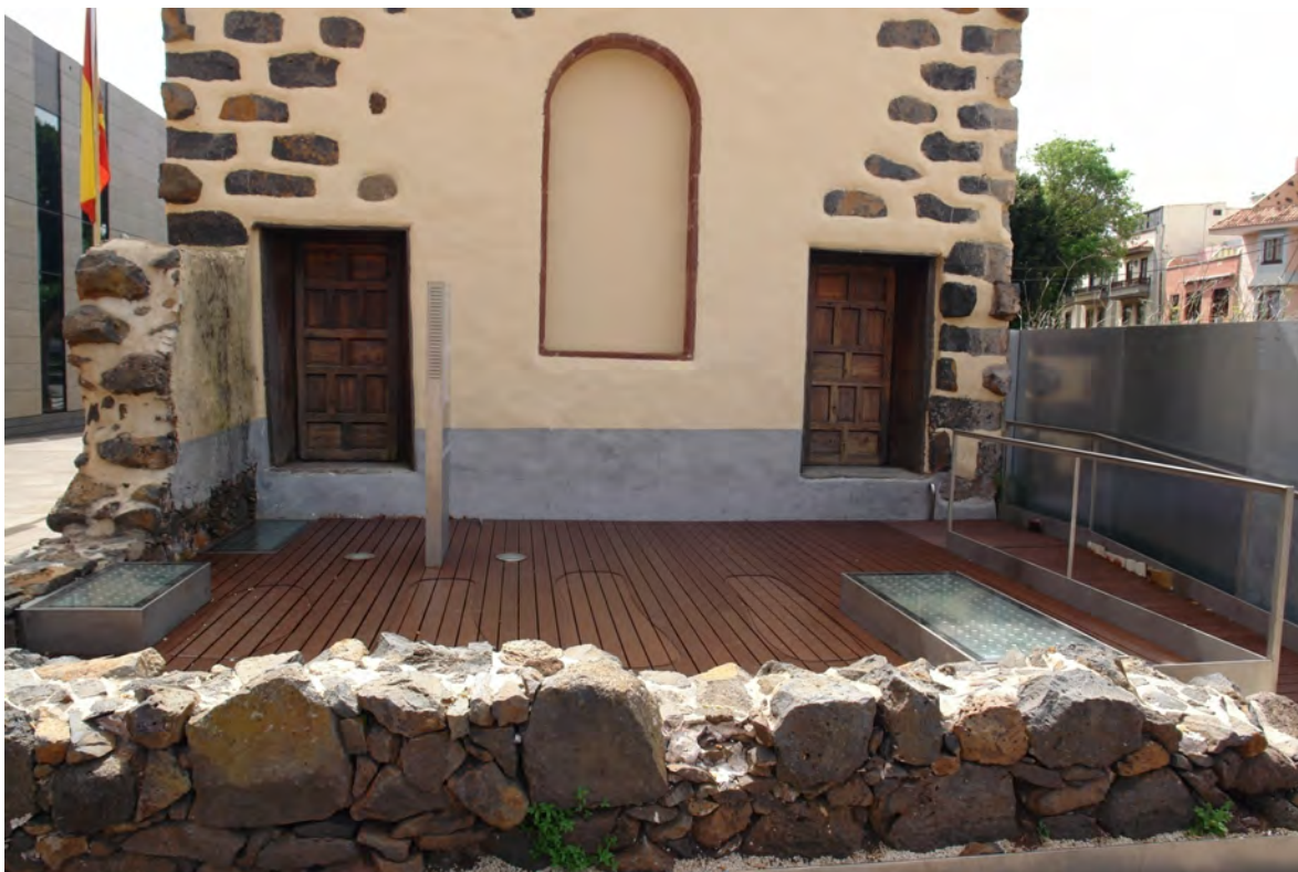
Trasera de la ermita de San Miguel, donde se conservan restos de los muros de la estructura primitiva del siglo XVI. (Foto: elaboración propia).
