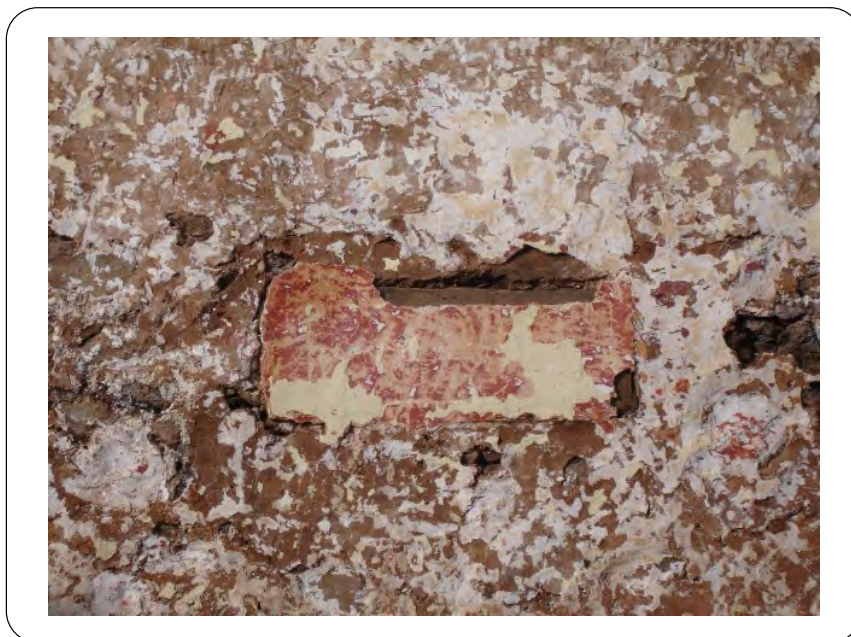
Paramento del convento por la calle de La Carrera-Obispo Rey Redondo. Se observa la guía de madera de un vano de una construcción anterior que, asimismo, se hallaba cubierto por el enfoscado. (Foto: elaboración propia).
