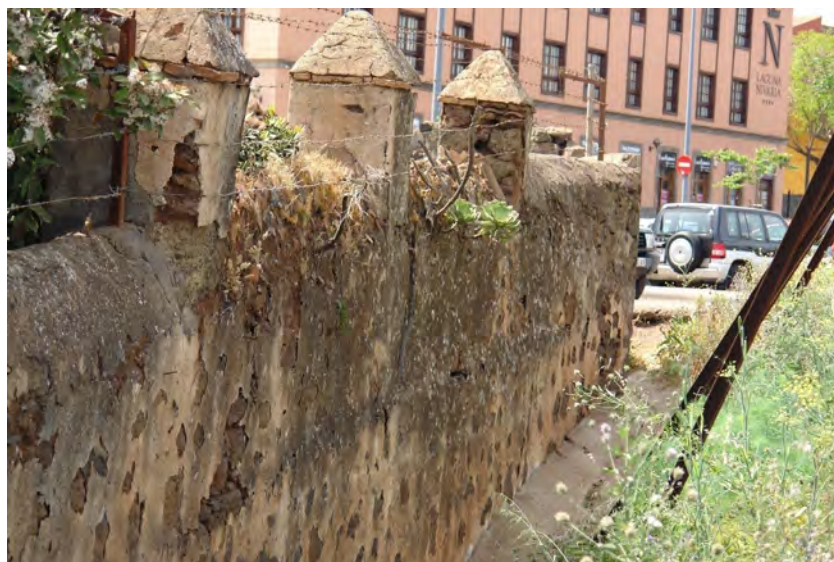
Paño del muro donde se ven las almenas o merlones y el remate triangular. El enfoscado es similar al de la ermita de San Miguel. (Foto: elaboración propia).
