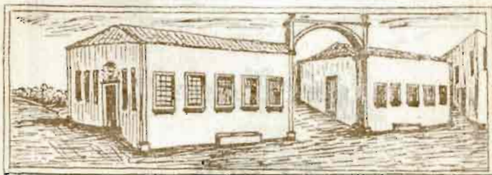
Vista del Palacio.
