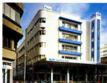
Edificio Ford Ford Building
