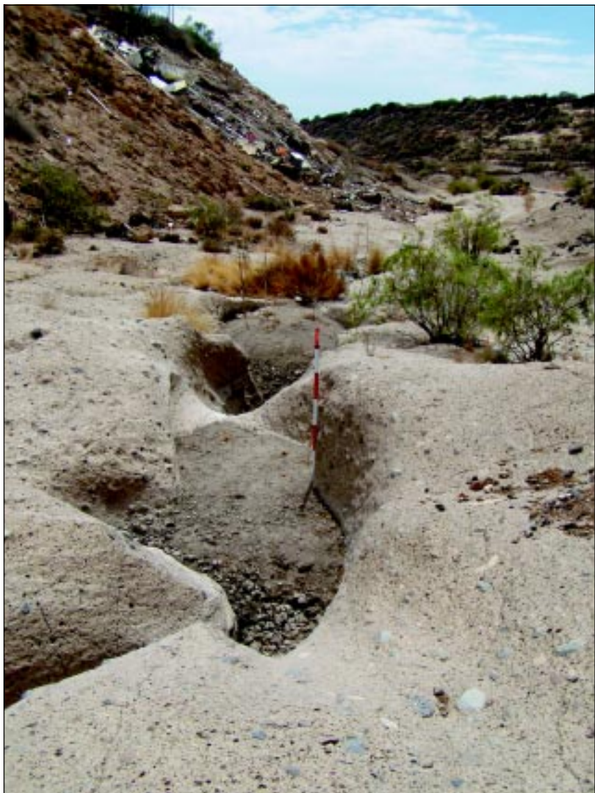
FIGURA 1.—Barranco de la Barca (Granadilla). Eres sobre tosca para almacenar agua de la lluvia que circula por el cauce del barranco.
