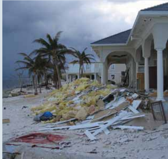
Impactos del huracán Iván sobre las costas no protegidas por el arrecife en Gran Caimán
