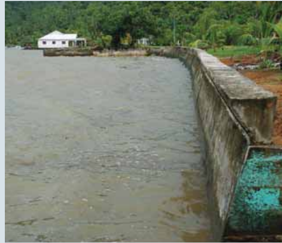
Muro de protección (Gahi Bay)
