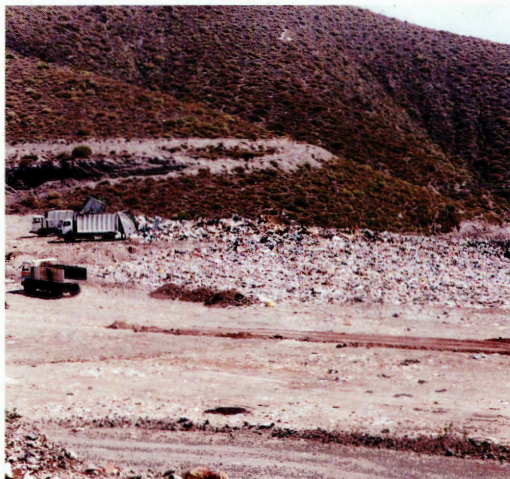
Fase I: vertido de residuos. Vertedero de El Salto del Negro (Gran Canaria).
