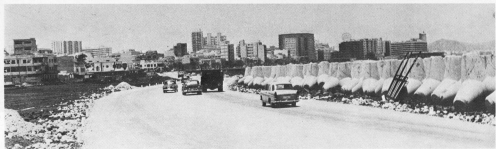
Ensanche de Las Palmas ganando terrenos al mar y construcción de la Avenida Marítima al Norte en los años sesenta.
