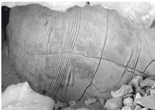
Abb. 25: Wasseraustritt aus einer Kluft
