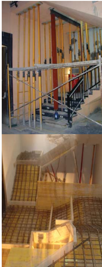
Sobre estas líneas, fotografías de detalles de la intervención: nivelación de la escalera con gatos hidráulicos previamente a su refuerzo. A la derecha, una imagen del interior del teatro. Abajo, dibujo de la planta principal del actual proyecto de rehabilitación.
