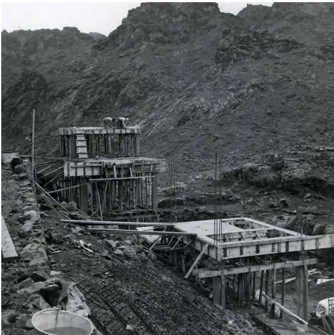
construcción de estructuras auxiliares para poder construir la presa bóveda
