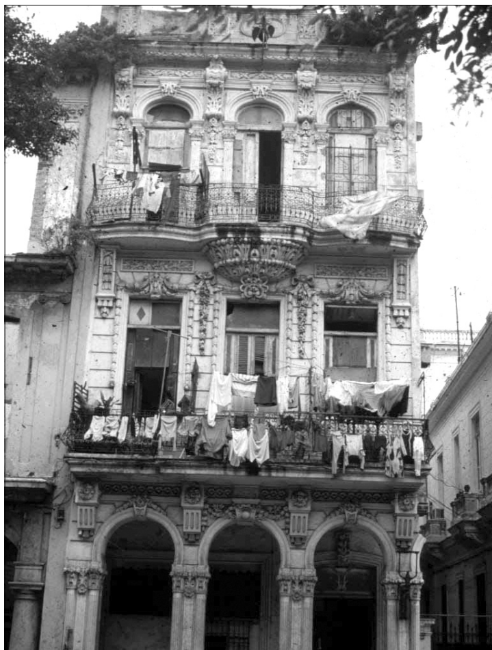
Edificio de la calle Simón Bolívar.
