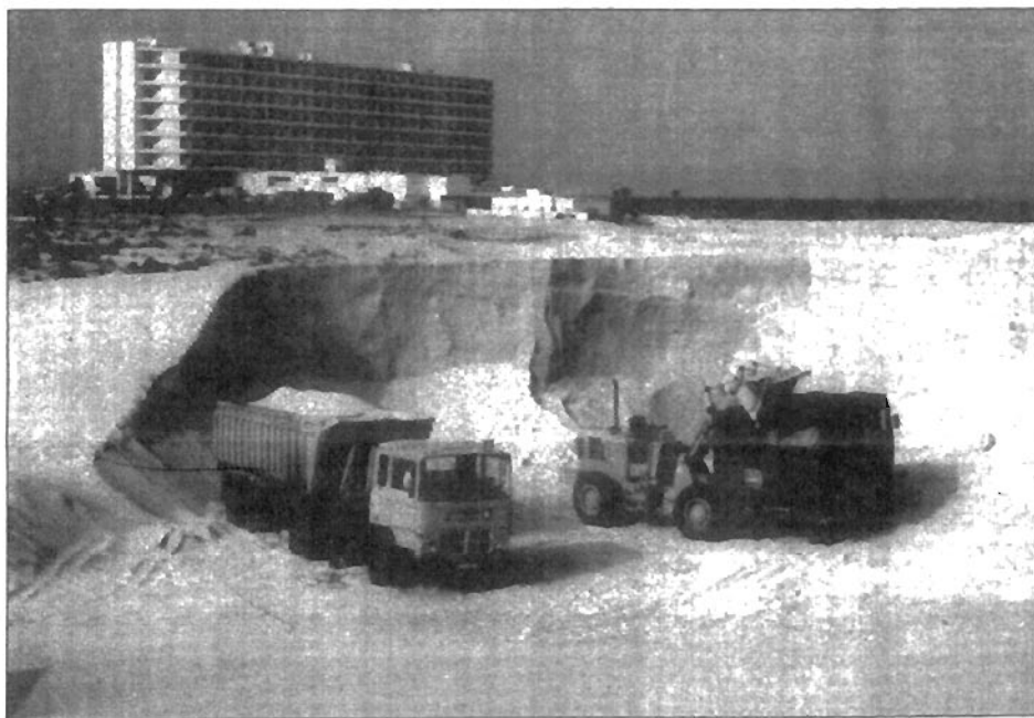
La dunas de Corralejo pueden verse afectadas por nuevos y extraños proyectos inmobiliarios.
