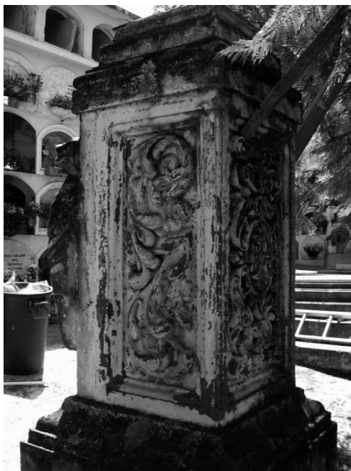
Fig. 10. Detalle de una tumba con elementos reutilizados en el cementerio de La Orotava.
