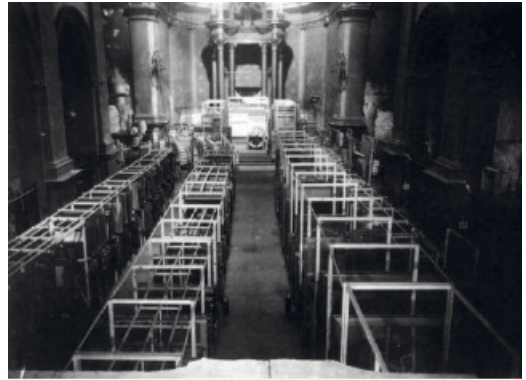
2. Habilitación de depósitos acondicionados 7
