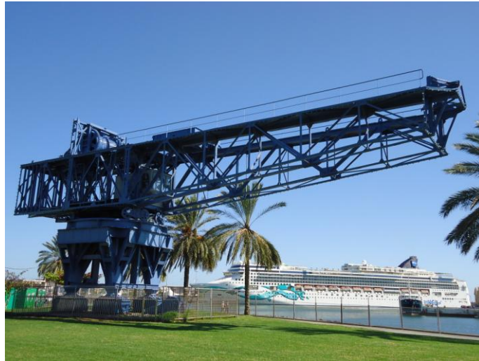
FOTO 4. Grúa modelo Titán, emplazada en la plaza del intercambiador de Santa Catalina (Las Palmas de Gran Canaria).
