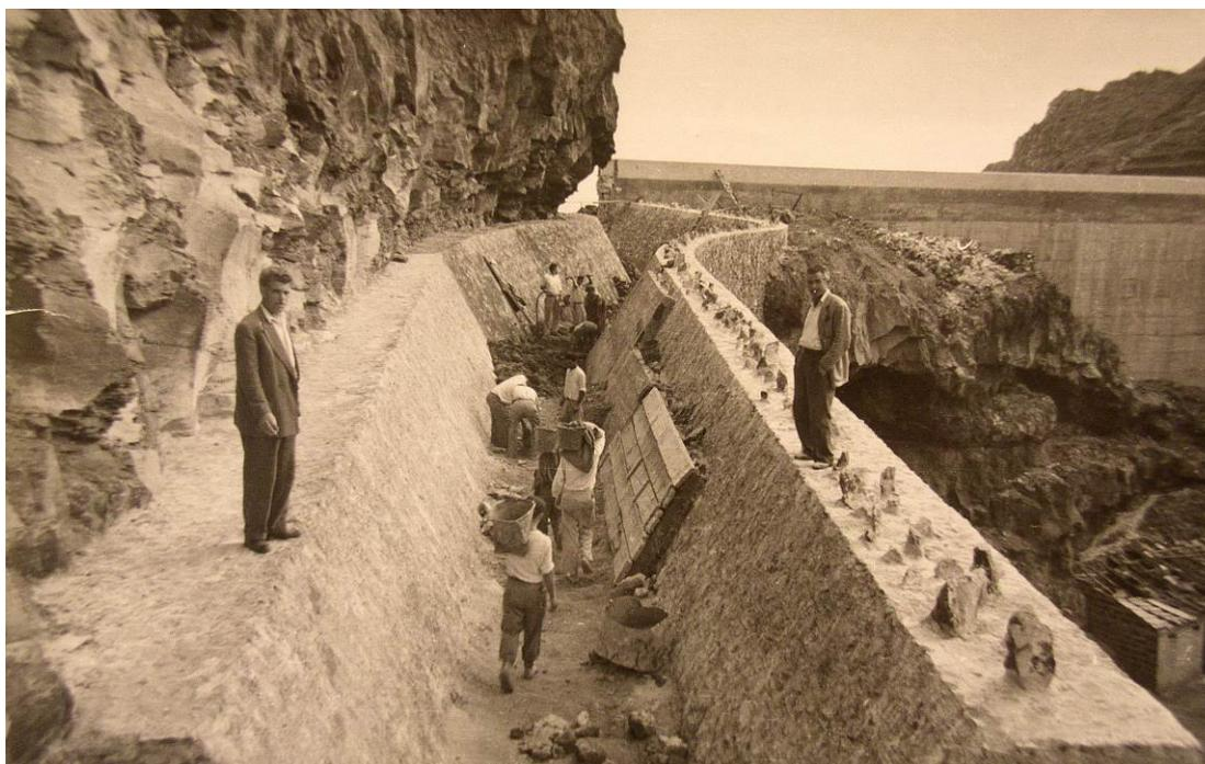
Fig. 6 – Construcción del aliviadero de la Palmita (M. Alonso - SVP)
