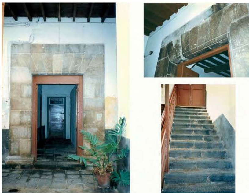
Fig. 14. Patio trasero de la casa Díaz Flores. Pueden verse las antiguas puertas de las sacristías y los escalones reutilizados.
