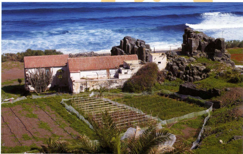
Casa de la Roca.
