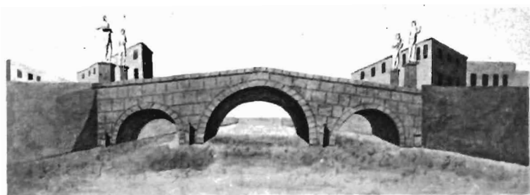
Puente de la Ciudad de las Palmas construido a expensas del Ill.º Sr. Obispo D. Manuel Verdugo y Alburquerque en 1816.
