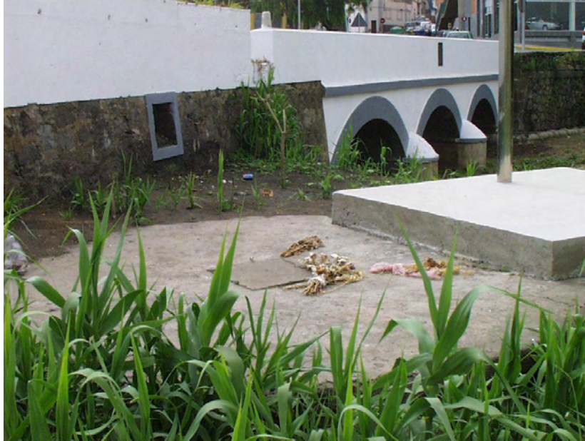
Fotografía V. Vista general del pozo del Puente del Barranco de Arucas. Foto: Concejalía de Patrimonio Histórico. Ayuntamiento de Arucas.
