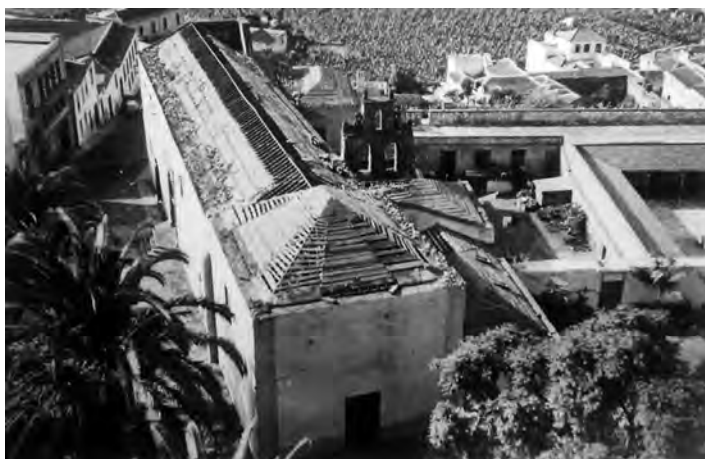
Foto 6. Derribo del Teatro Power en 1953.
