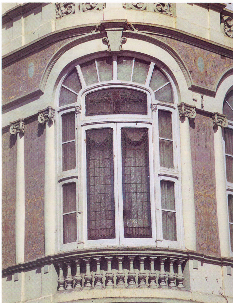
Ventana esquinera de la fachada
