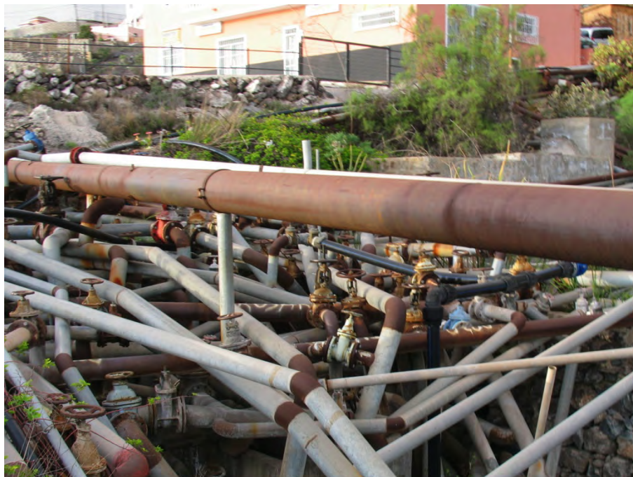
Figura 10 ; en algunas zonas de las islas la multiplicidad de líneas de transporte de gestión hace muy difícil la gestión hidráulica , sólo en la isla de Tenerife existen 4000 kilómetros de conducciones.
