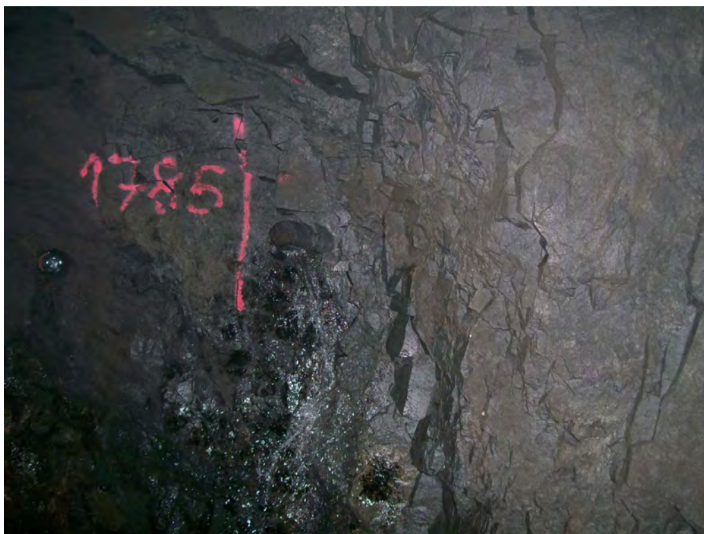
Figura 3 ; fisura con aporte de agua dentro de una mina de agua en la isla de La Gomera , se observa que la longitud a la que nos encontramos dentro de la explotación es 1.785 metros, es necesario perforar con mucha precaución y con un sondeo horizontal de al menos 50 metros para detectar bolsas de agua tras los diques.
