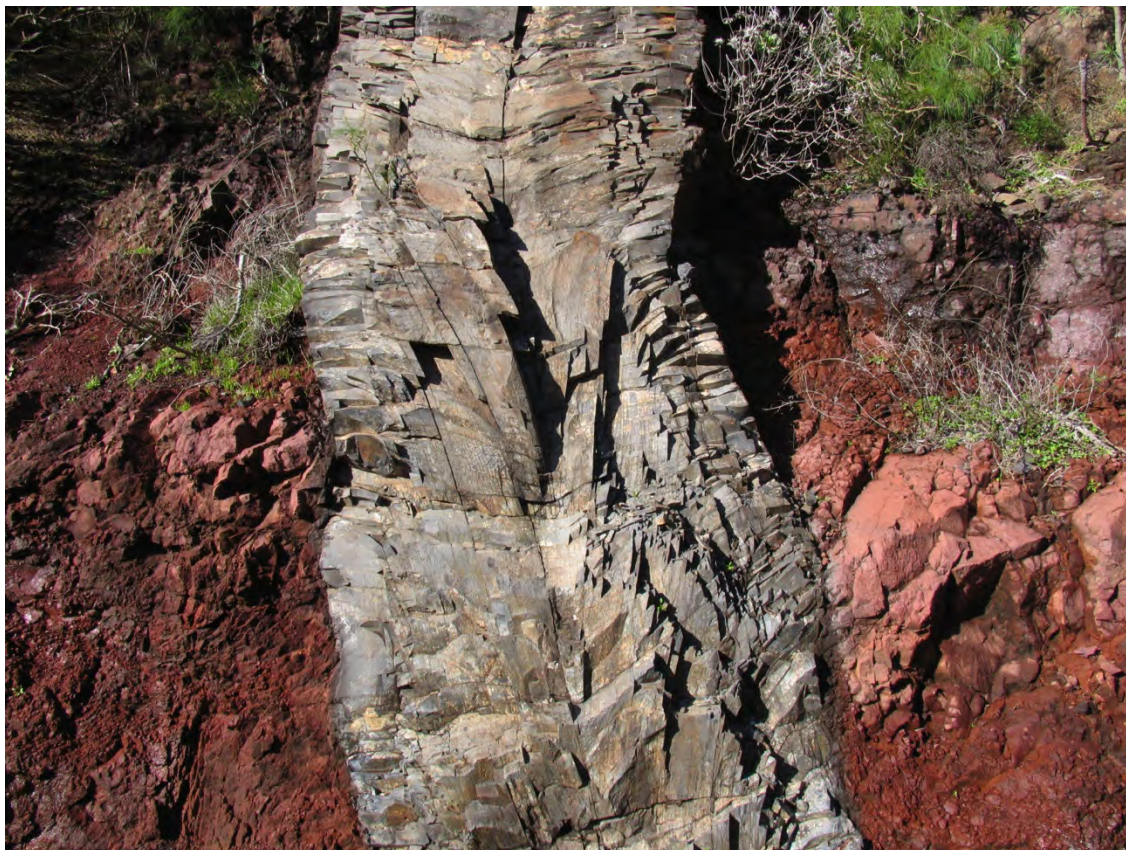
Figura 2; Un dique geológico atravesando el terreno, nótese la regularidad de la roca y la compacidad de la misma, salvo que presente un estado de fisuración importante, se puede considerar como una estructura impermeable.
