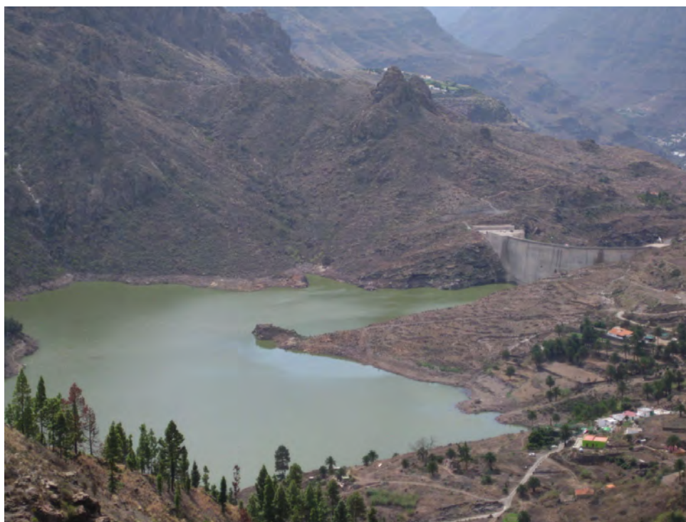
Figura 8; vista del embalse de Soria en la isla de Gran Canaria, su construcción duró 10 años, tiene una altura de 120 metros y una capacidad de 32 \text{ hm}^3 , aunque nunca ha sobrepasado los 15 \text{ hm}^3 , el muro de presa es de los más altos de España.
