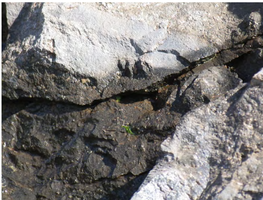
Figura 1; Fisura con agua en basalto compacto, el agua transcurre por gravedad de cotas elevadas hacia las de menor altitud, en ese camino discurre por diversos materiales, unos impermeables como los paleosuelos, diques ... y otros más permeables como las escorias de las coladas, las fisuras . El buzamiento de las coladas es muy importante también a la hora de condicionar los movimientos del agua en un terreno volcánico.
