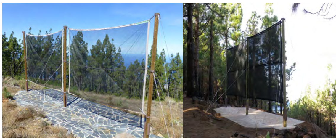
Ilustración 3; Atrapanieblas (12 m 2 /c/u) construidos por el Cabildo Insular de Tenerife para coleccionar agua del mar de nubes en El Gaitero y en Fuente del Joco, Tenerife. (© Marzol, M a V. y García, P. respectivamente)
