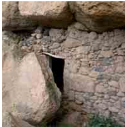
Cerramientos de mampostería ordinaria con juntas de piedra seca o de mortero de adobe. Cueva en Tara, Telde.
