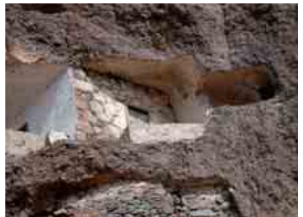
Casa cueva en sustrato de escorias volcánicas compactadas. Tejeda.
