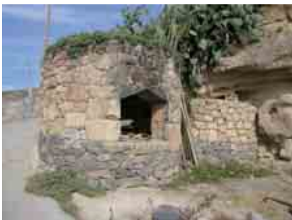
^ Horno en La Atalaya, construido con toba volcánica de color amarillento.
