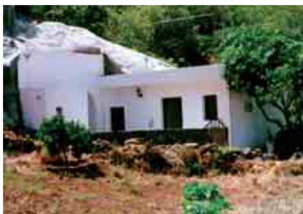
^ Casa cueva con baño y cocina adosados en el exterior. Fagagesto, Gáldar.
