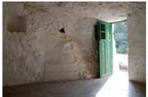
El empleo del blanco mejora las condiciones de luminosidad de las estancias interiores. Cuevas del Andén, Valleseco.
