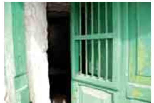
La falta de ventilación de las cuevas se resuelve con este tipo de elementos. Cuevas del Andén, Valleseco.
