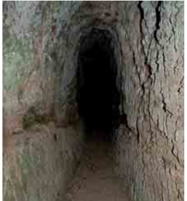
Galería de agua en el Barranco de la Virgen. Valleseco.
