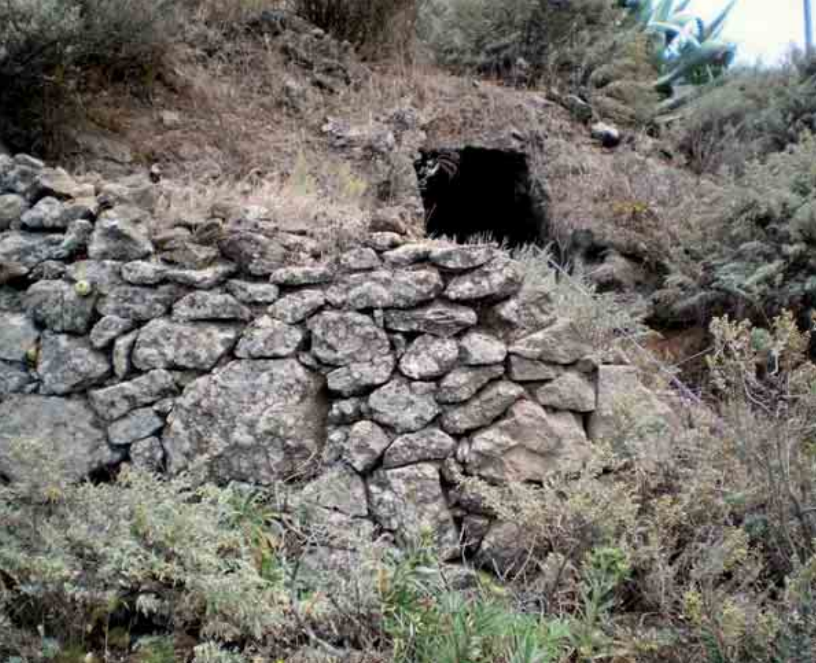
^ Vista de los retos del muro del horno de sistema de calles y cueva almacén de la locera Felipa Suárez, Lugarejos, Artenara.
