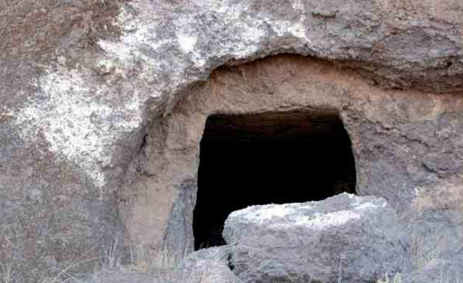
Ejemplo de derrumbe en la entrada de una cueva.
