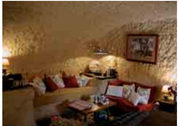
Interior de cueva donde el vano describe un pequeño arco para repartir mejor la carga. Casa cueva de turismo rural El Ciruelo, Vega de San Mateo.
