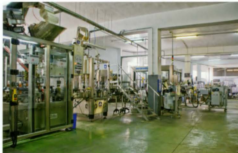
Planta embotelladora de Destilerías Tejina en la actualidad. (Fondo documental de Destilerías Arehucas S.A.).
