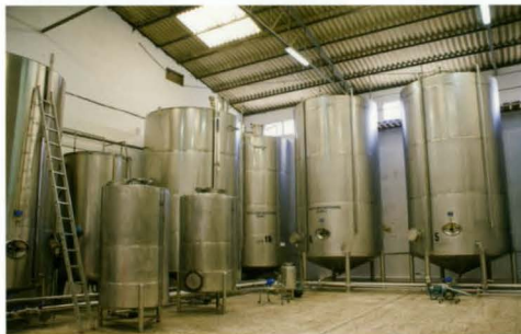
Depósitos de Destilerías Tejina en la actualidad. (Fondo documental de Destilerías Arehucas S.A.).
