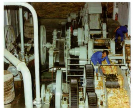
Detalle del molino antes de 1984. (Fondo documental de Destilerías Arehucas S.A.).
