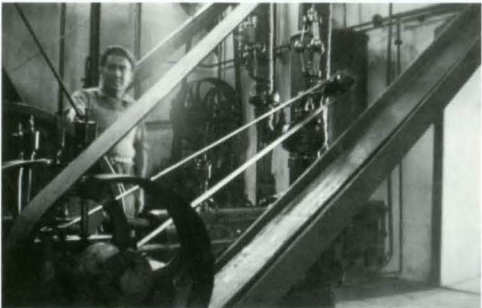
Cinta transportadora del Molino. (Fondo documental de Destilerías Arehucas, S.A.).
