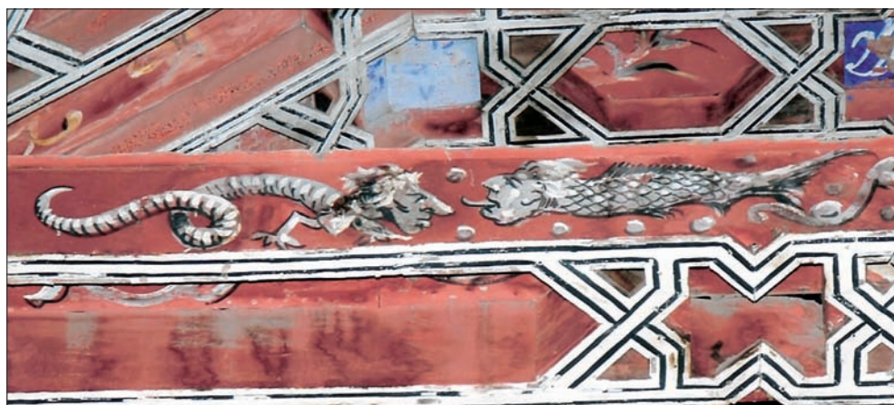
Figuras antropomorfas —el pez y la serpiente— en un tirante de la armadura correspondiente a la nave de Nuestra Señora del Carmen en la iglesia de El Salvador. Arch. F. Daranas.
