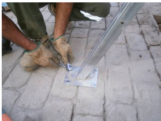
Anclaje al suelo mediante placa y barraqueros.
