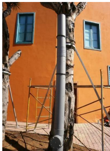
Tubo de 200mm con registro a 50cm del suelo.
