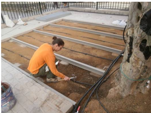
Colocación de goteros en zona de ampliación
