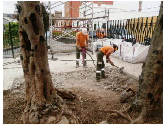
Proceso de demolición de la losa.
