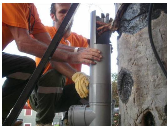
Instalación de tubo de 110mm con dos registros-mirillas.
