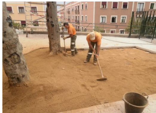
Vista general del aporte de tierra.
