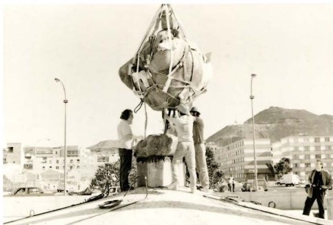
Tony Gallardo dirigiendo los trabajos de construcción de la fuente El Callan . 1987.
