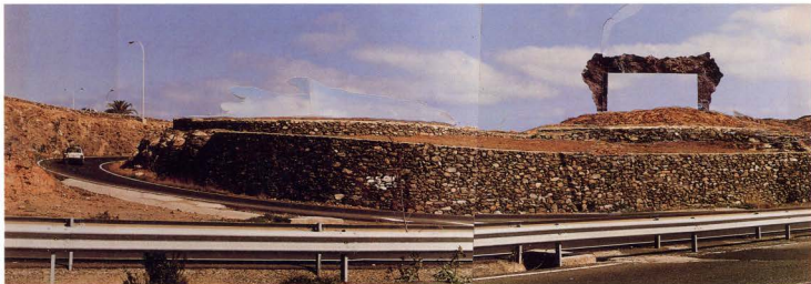
Pórtico. Proyecto para Museo Internacional de Esculturas al Aire Libre en la ciudad de Telde (Gran Canaria), en construcción. 1992.
