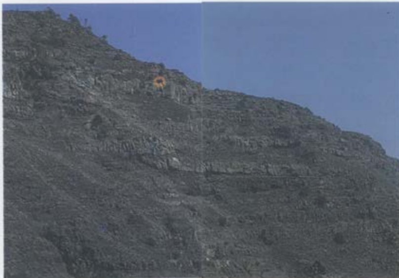
La erosión ha dejado al descubierto la estrudel escarpe de Las Playas
