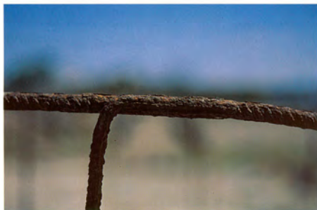
Foto 57. Varillas del armazón soldadas.
