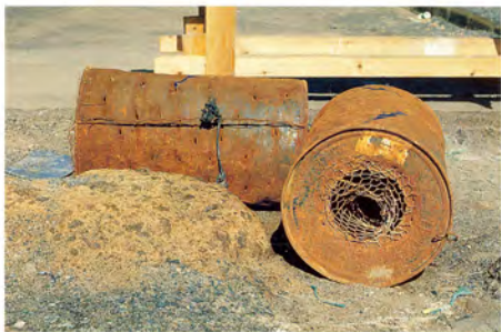
Foto 89. Tambores de profundidad en desuso. Puerto de Taliarte.
