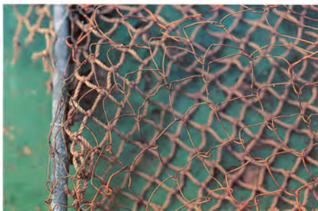
Foto 32. Detalle de una gueldera de cobre reparada con paño de red.
