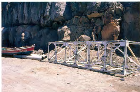
Foto 64. Estructura para la fabricación de arrecifes artificiales. Puerto de Mogán.
