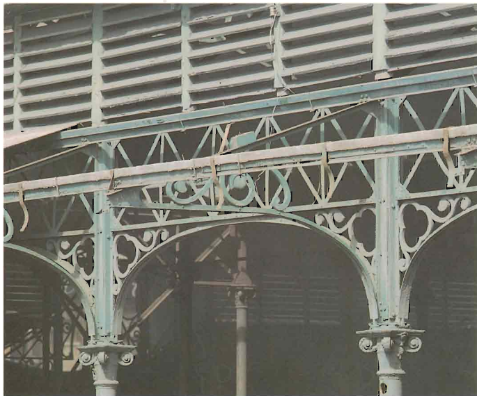
El Mercado del Puerto basa el éxito de su arquitectura en el uso que hizo en 1910 el arquitecto Arroyo de las piezas de hierro fundido adquiridas en Bélgica
