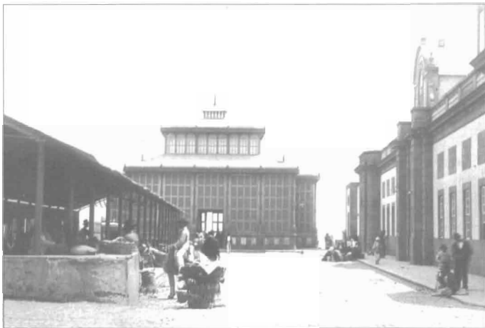
Ante la gran demanda de puestos de venta el Ayuntamiento capitalino accedió a la instalación de un tinglado de hierro frente al Mercado de Vegueta
