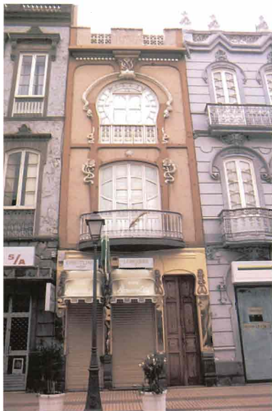
En 1874 comenzó una importante reforma de esta tienda, un establecimiento que tomó su aspecto definitivo en 1907 de la mano de Miguel Rodríguez del Toro con una intervención del arquitecto Navarro.
