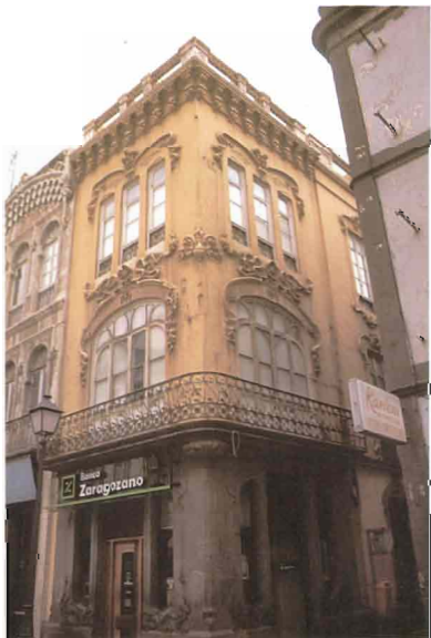
Manuel Apolinario le encargó en 1907 al arquitecto Fernando Navarro y Navarro el que fue sin duda el mejor ejemplo de arquitectura modernista de la ciudad.
