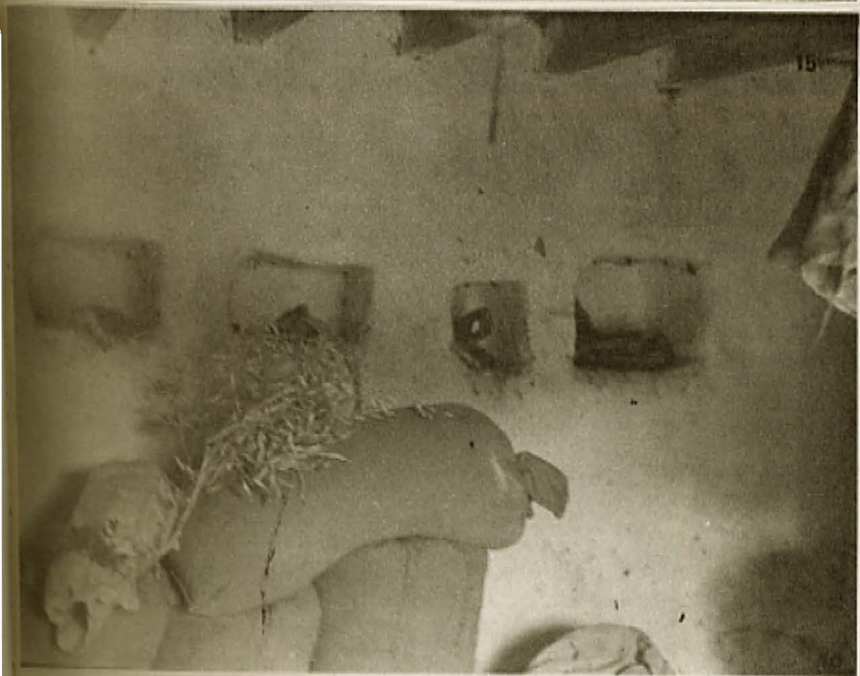
OBRAS DE CARACTER SINGULAR Y FUNCIONAL: Ermitas, molinos, hornos, tahonas, algibes, puertas... Todas en trance de desaparecer.
