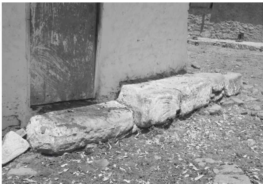
Fig. 12. Grandes sillares empleados en la base de la vivienda. Estado actual.
