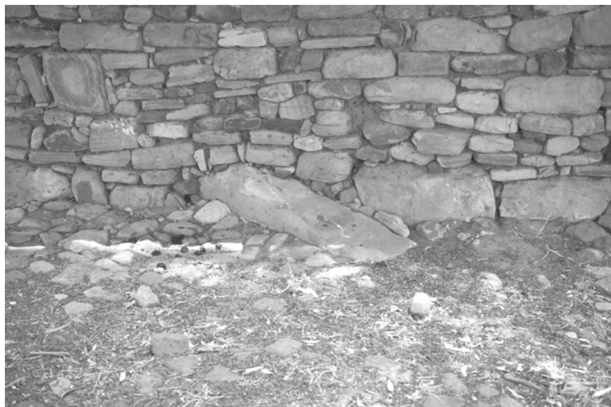
Fig. 7. Monolito y sillares reutilizados en la base de una vivienda.
