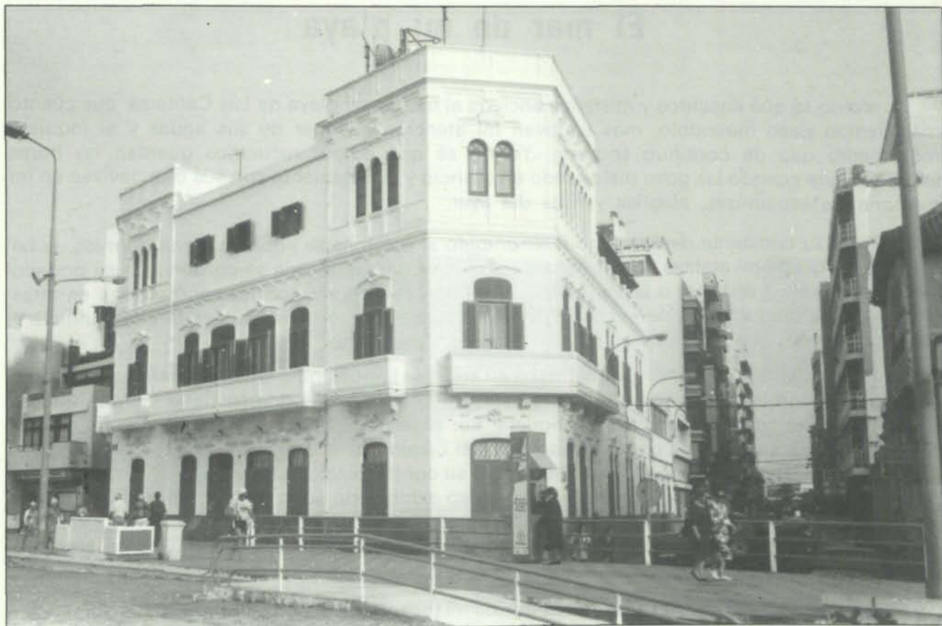
Comandancia Militar de Marina (antiguo Hotel «The Tower») en la playa de Las Canteras
