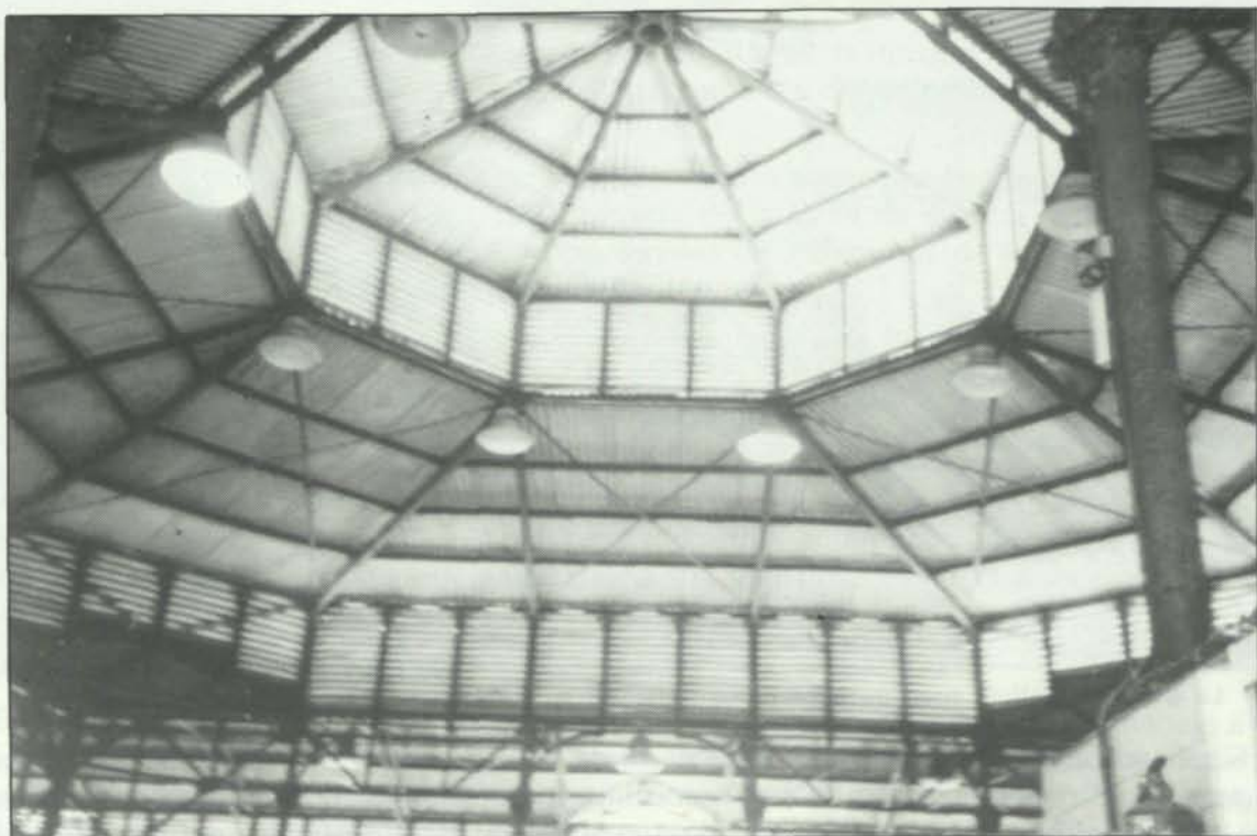
Detalle de la cúpula del Mercado del Puerto
