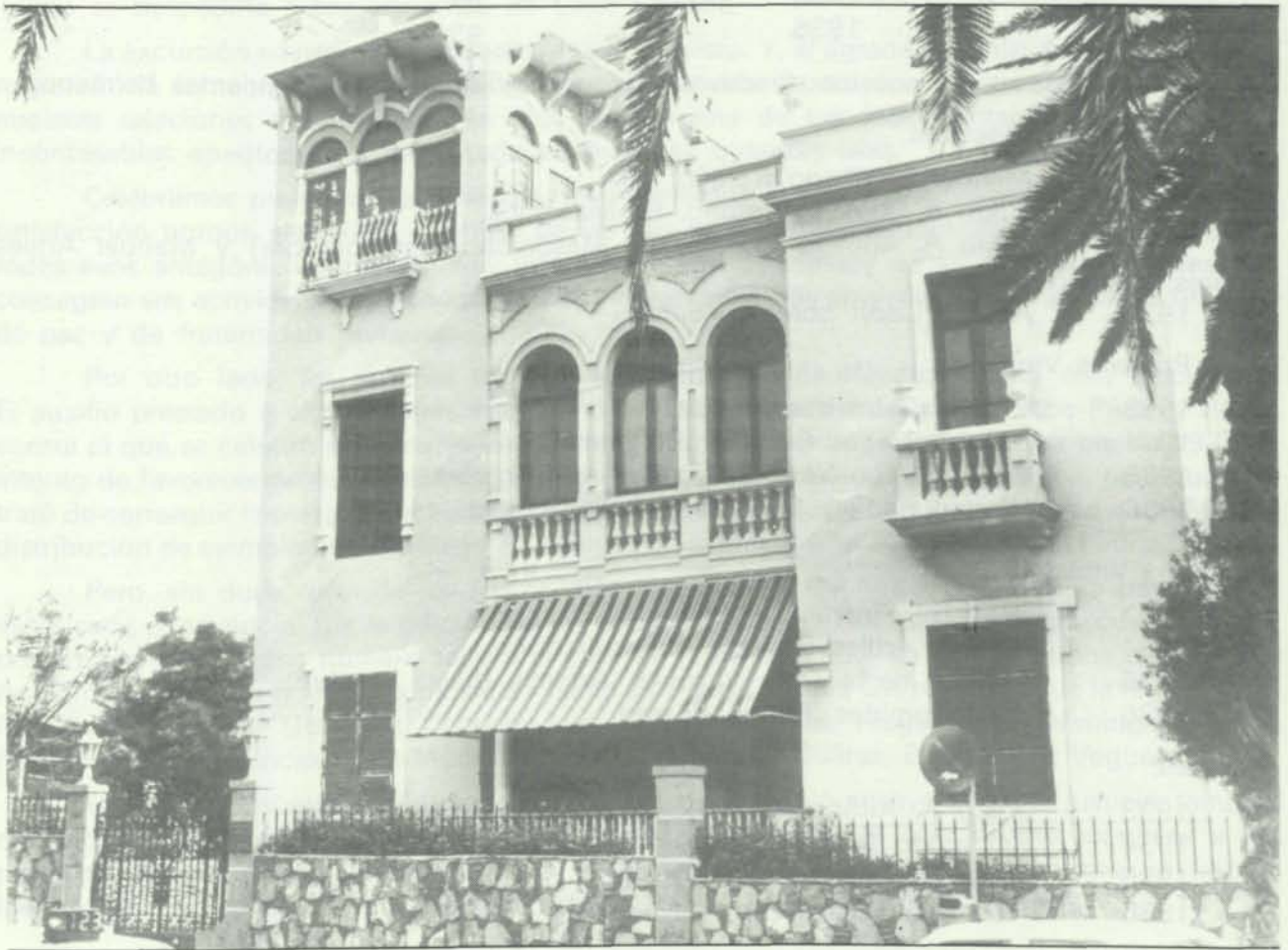
Edificio de la Logia Andamana nº 3 de Las Palmas. Hoy, casa del Hierro
