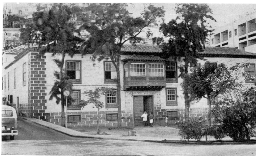
Puerto de la Cruz. Fachada principal de la casa de Ventoso.
