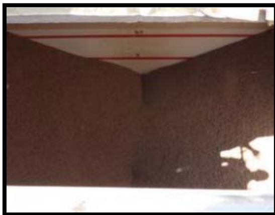
Silo de pellets en hotel
