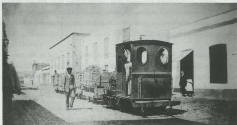
Locomotora de la Compañía Anónima de Construcción del Puerto del Arrecife por la calle Real, tras cargar piedras en la pedrera del "cabo Pedro". 1910
