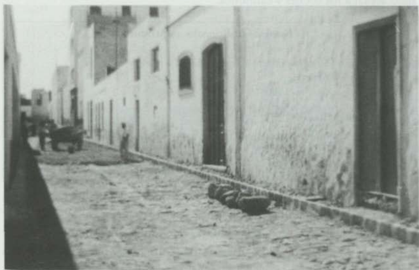
Calle de Arrecife en 1960, donde se aprecia el típico empedrado
