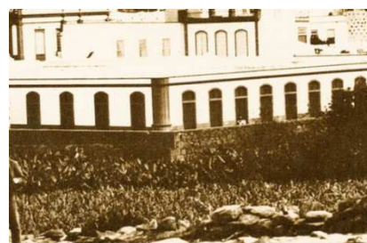
123. Muros de contención
