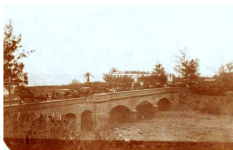
64. El puente que se quedó chico
