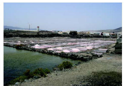
A la izquierda, imagen parcial de las salinas con una de las casas ya restaurada. Sobre estas líneas, las edificaciones antes de la restauración y una vista general de la zona.
