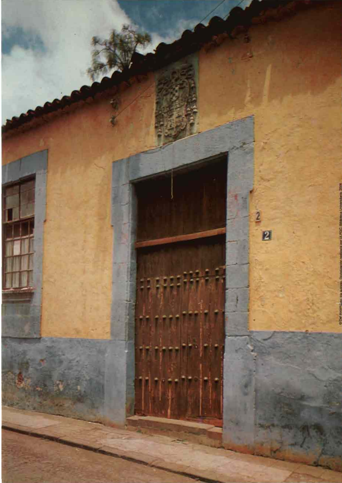
Fachada de la primera ala del palacio episcopal.
