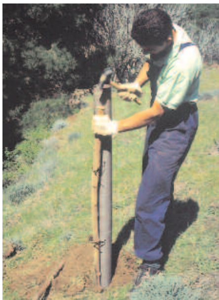
Colocación del ecotubo.
