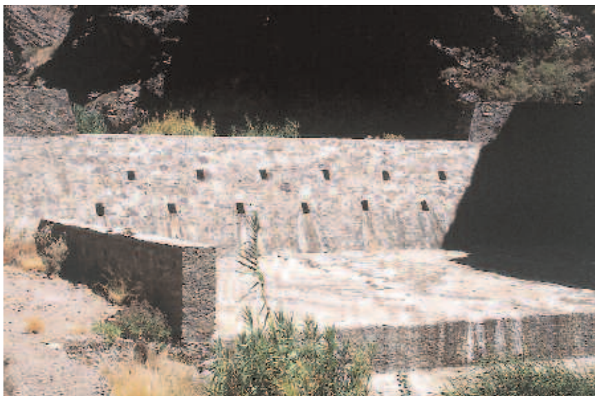
Corrección hidrológica con la ayuda de diques.
