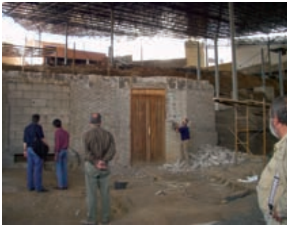
■ Fotos 15. Detalle del desmonte de la fachada.
