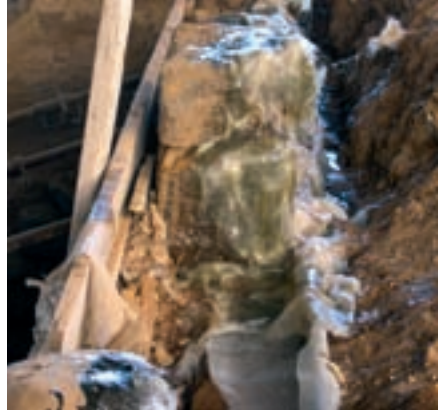
■ Foto 24. Reforzamiento posterior de un muro con poliéster y fibra de vidrio.
