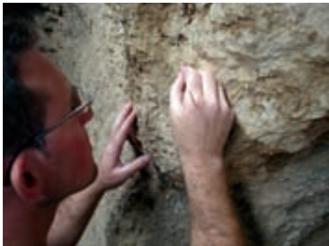
■ Foto 16. Retirada de los empapelados que protegían las paredes de toba.
