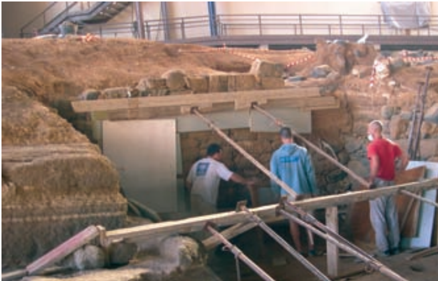
■ Foto 23. Reforzamiento de muros.
