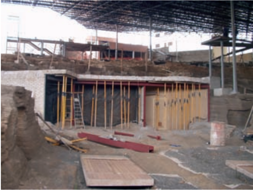
■ Foto 16. Apuntalamiento y construcción del pórtico.
