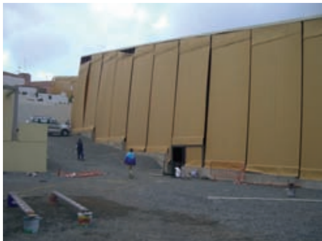
■ Foto 9. Los cerramientos laterales. Absorción de diferencias orográficas y de nivel.
