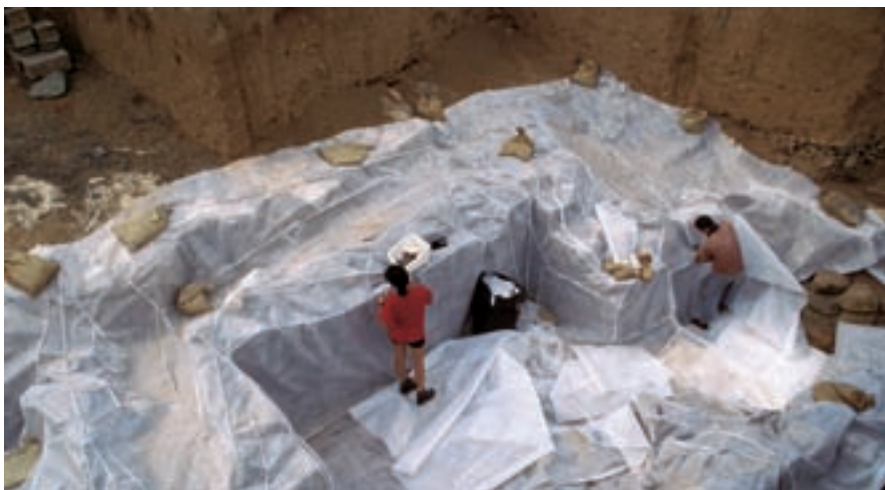
■ Foto 3. Estructura cubierta con geotextil.
