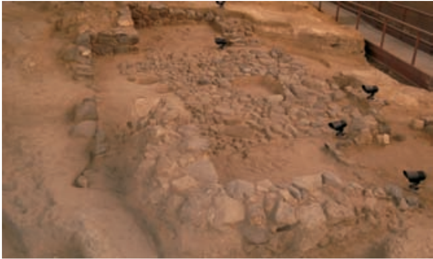
■ Foto 25. Trabajos de restauración en su fase final.
