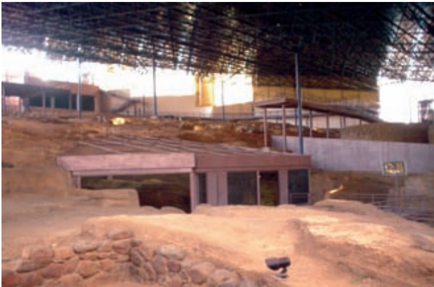
■ Foto 3. Vista del nuevo cerramiento de la Cueva Pintada bajo la cubierta general.
