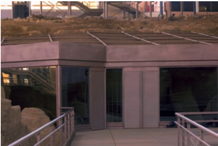
■ Foto 22. Vista parcial una vez concluido el nuevo cierre.
