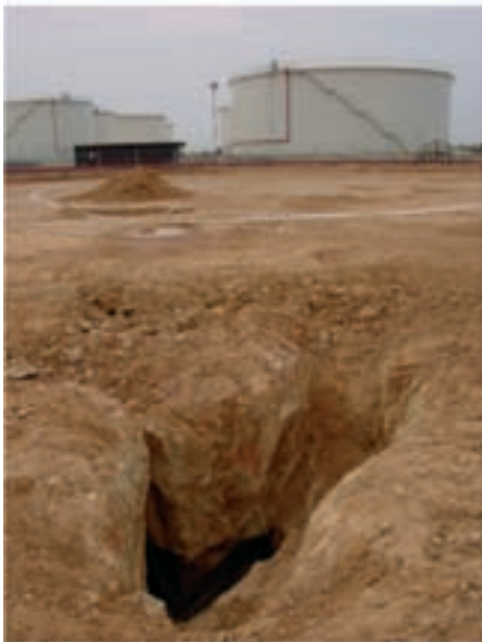
■ Foto 1. Cata efectuada en el futuro emplazamiento de un depósito de combustible, descubriendo la oquedad determinada por la prospección con georradar, mostrada en la figura 3.
