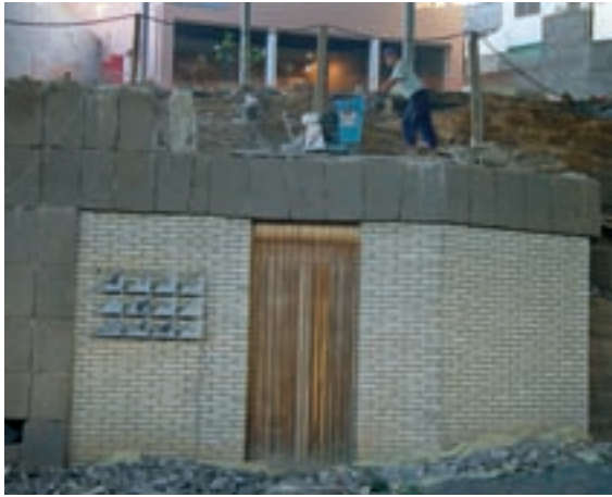
■ Fotos 14. Demolición controlada del forjado superior.
