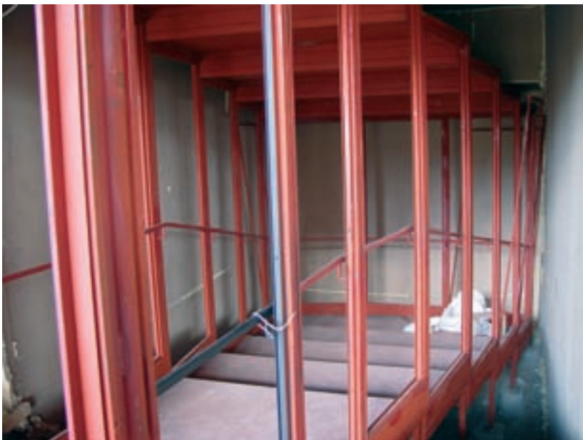
■ Foto 19. Estructura completa de la «burbuja».
