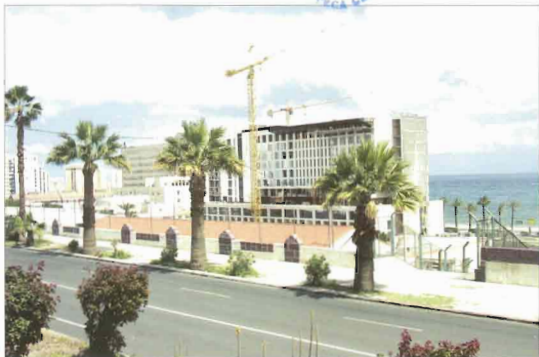
Hospital Insular y obra de ampliación
