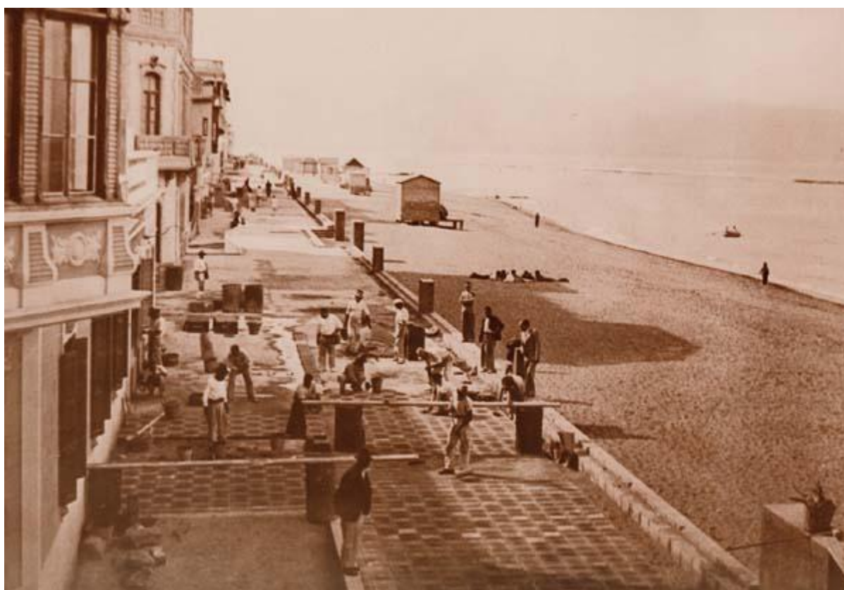
15.- Obras de construcción del paseo de Las Canteras en 1940. FEDAC, Cabildo de Gran Canaria.
