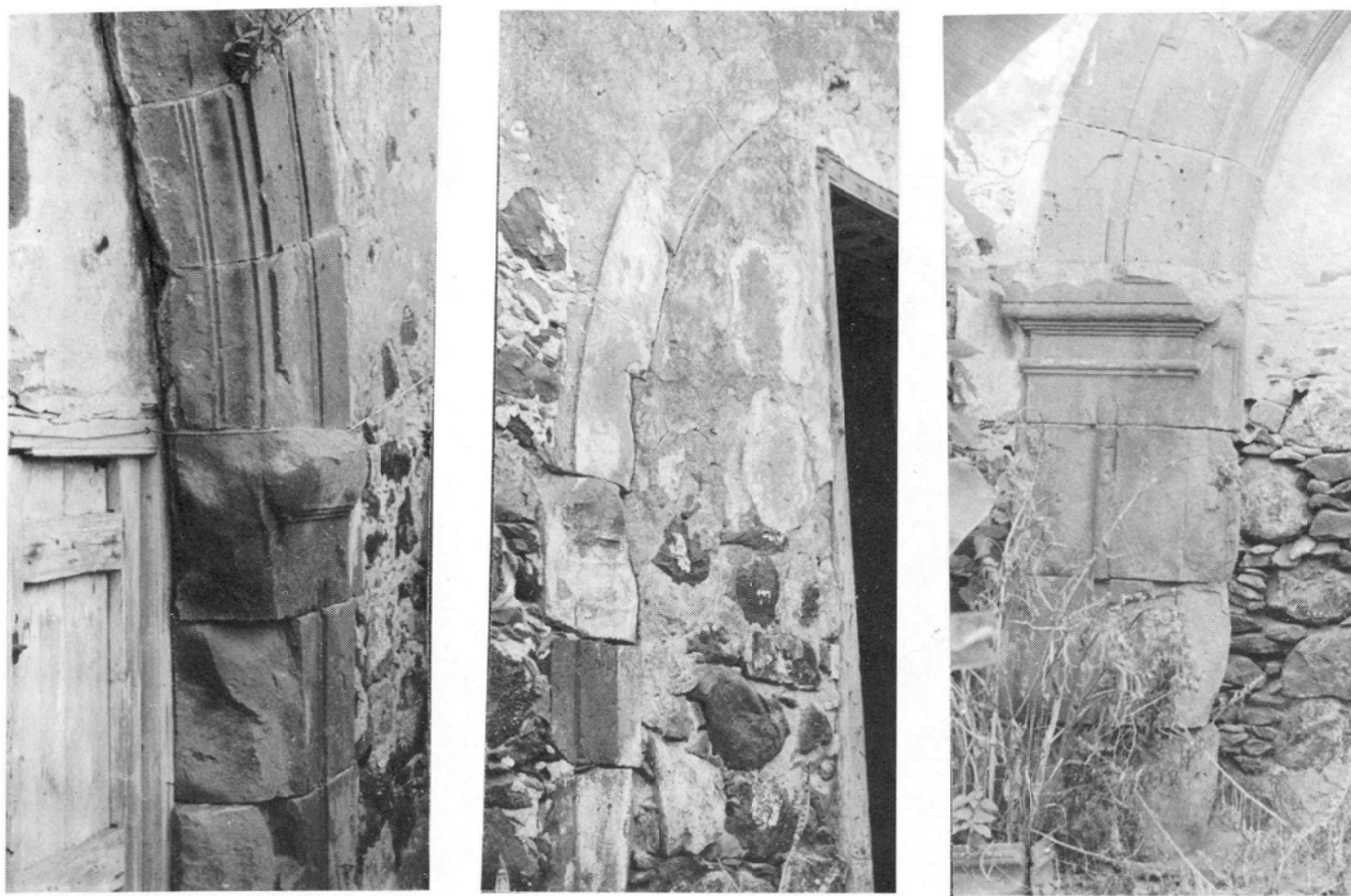
Fig. 13. —Detalle de antiguos arcos de cantería del convento de los agustinos de Garachico, situados en la zona de las celdas.
