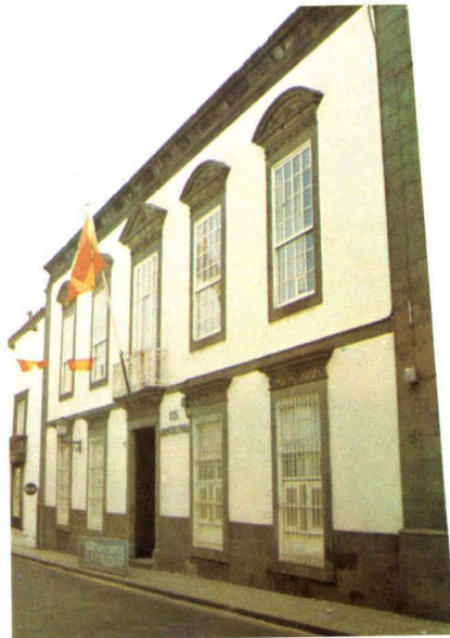
7 - Escuela Técnica Superior E. T. S. Arquitectura.
